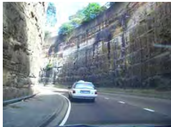
写真 - 2 岩盤直切りで掘り込んだ道路
