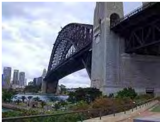
写真 - 1 ハーバーブリッジ
