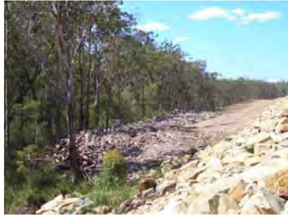
<ボックスカルバート間は柵を張り巡らす予定>
