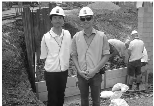
病院の建設現場にて
