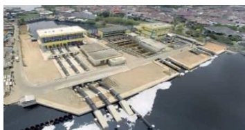
【水資源・治水分野】インドネシア国プリーツ排水機場緊急改修計画
