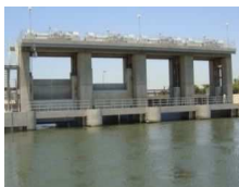
エジプト：灌漑施設の改修に係る調査・計画・設計・積算・施工管理
